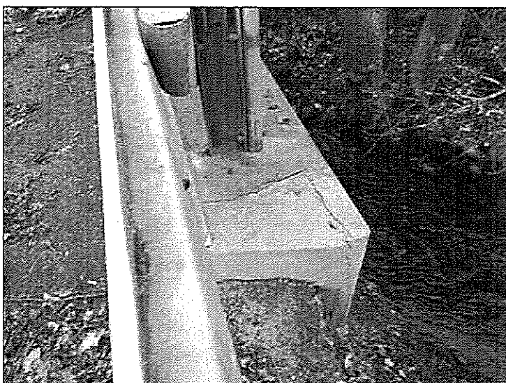
Trhliny v římsách
